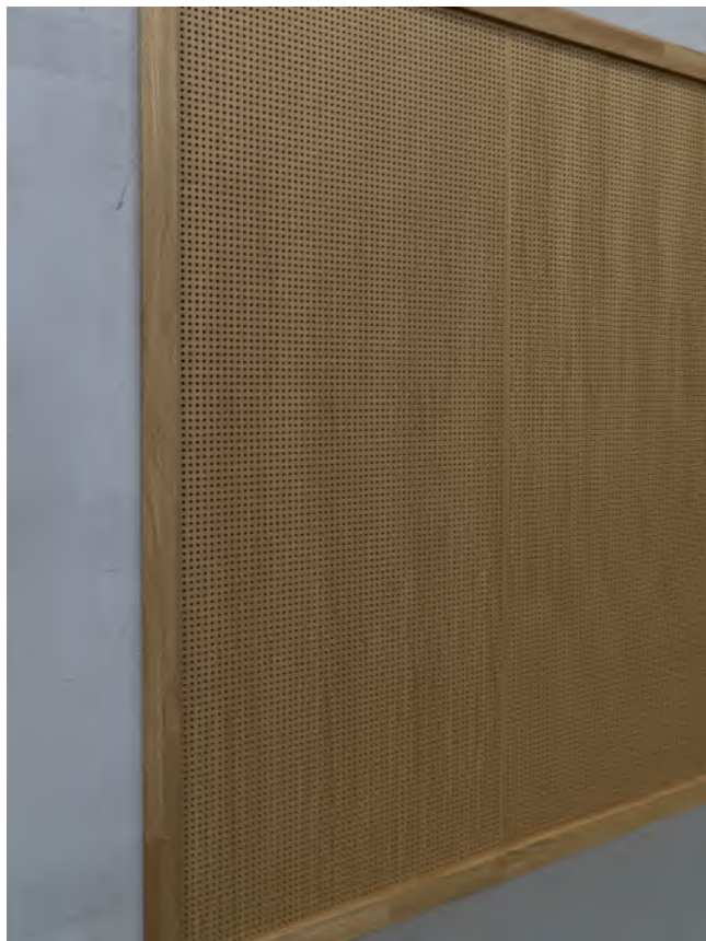
akoestische lambrisering met houten fineer
