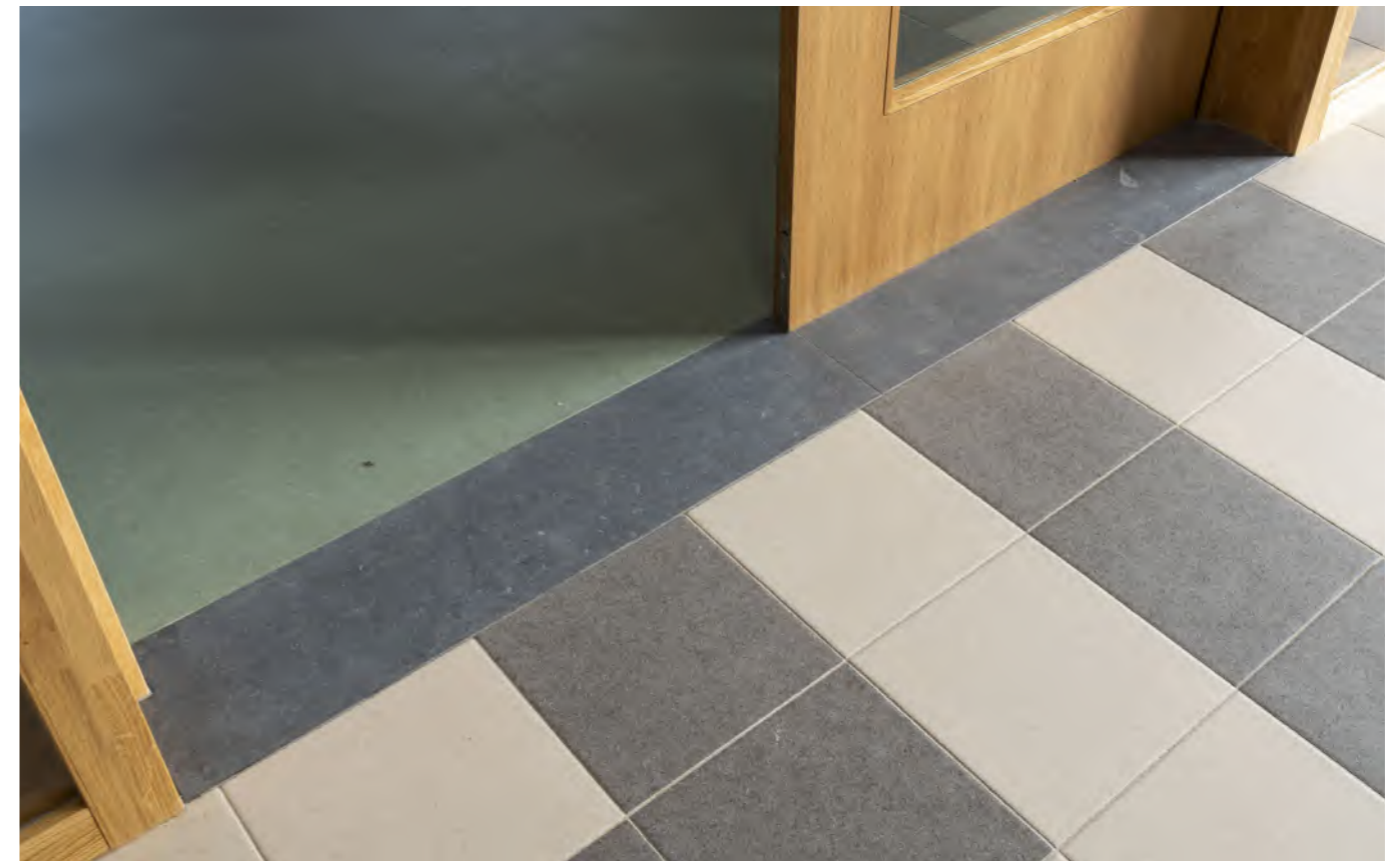
overgang tussen twee verschillende vloerafwerking met hardsteen
