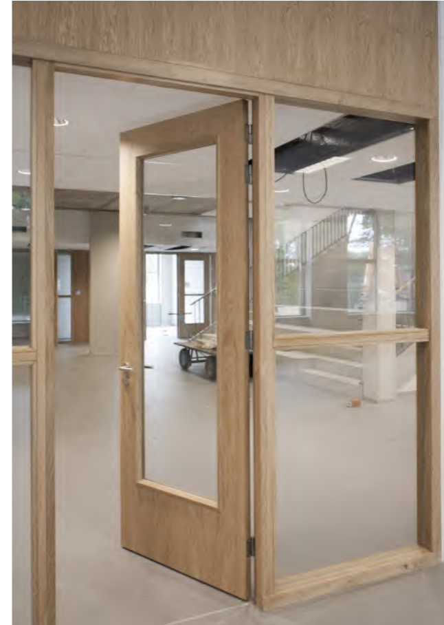
houten kozijnen met afdeklatten
