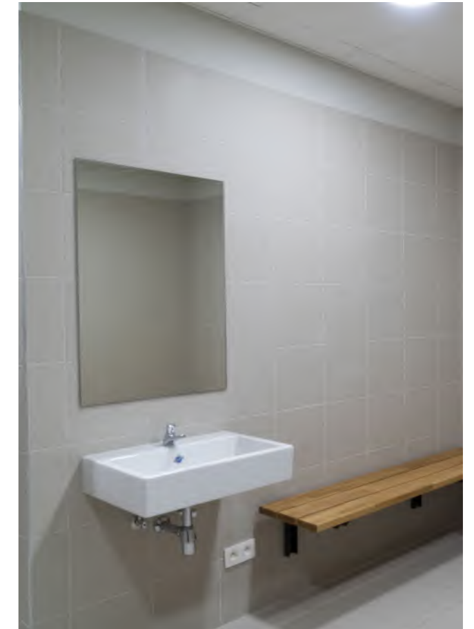
losse keramische wastafels, bakjes staal en hout
